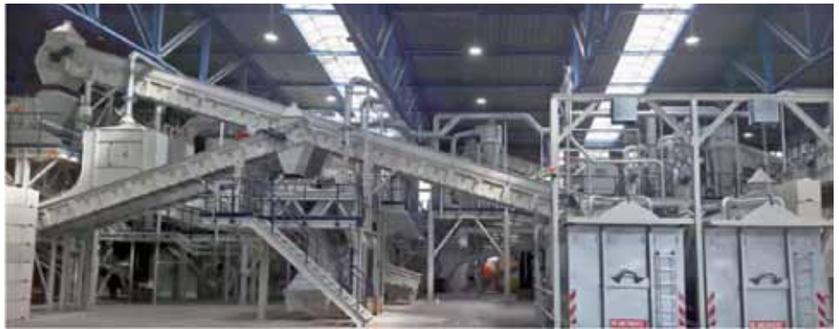
Der Standort in Zweibrücken eignete sich optimal für die Errichtung einer Gipsrecyclinganlage
